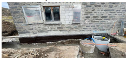
Figura 5 – Nuova infrastruttura e sistemazione piazzali
